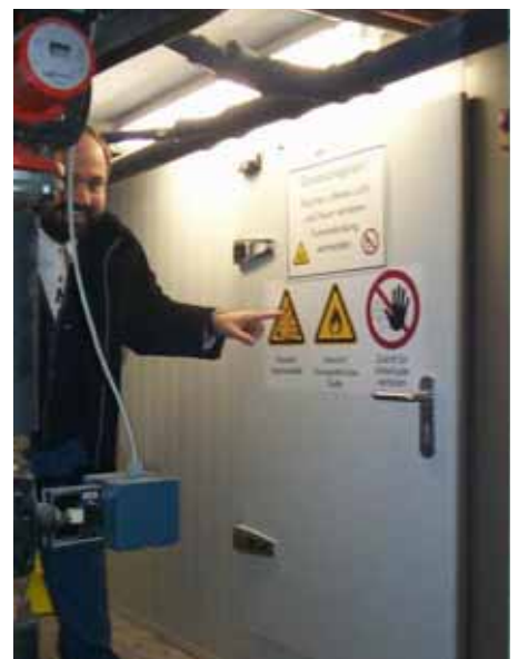
Bild 3 Der besondere Maschinenraum im Maschinenraum
