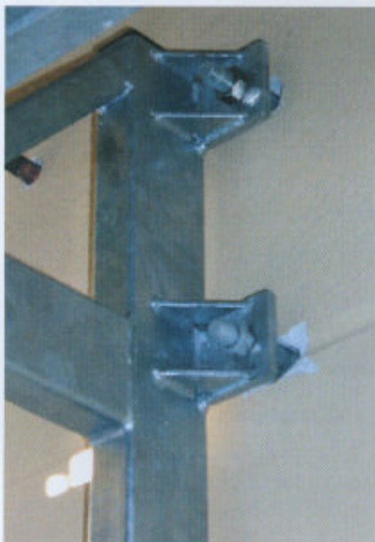
Bild 2 + 3: Die Konsole wurde nicht direkt an die Wand geschraubt, sondern frei aufgestellt
