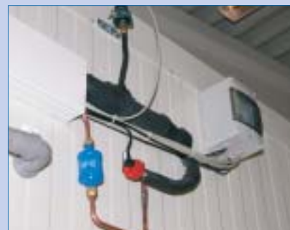
Bild 6 unten im Kasten: Ein elektronisches Expansionsventil eingesetzt bei Ökoring
