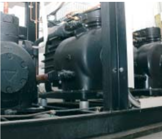
Bild 7: Die HKT Goeldner-Verdichter. Zwei für die Normal-, einer für die Tiefkühlung – und alle für den R410A-Betrieb freigegeben
