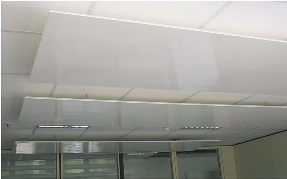
Bild 4 Raum mit Deckensegeln
