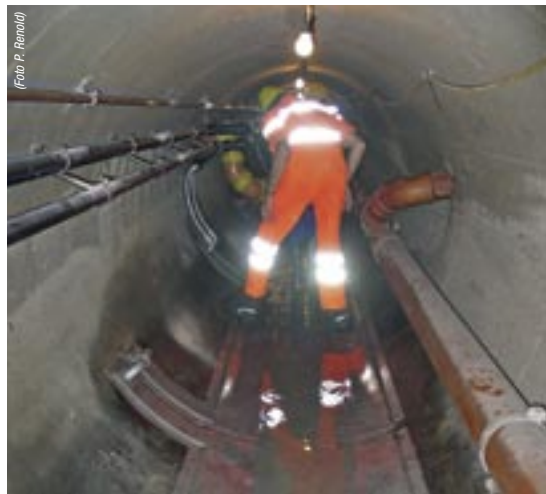
Wärmetauscher im Abwasserrohr eingebaut
