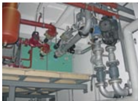
Anschlüsse der Kalt- und Heizwasserleitungen sowie der Zylinderkopfkühlung seitlich am Monoblock
