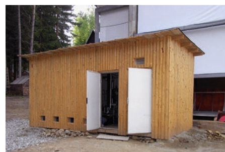
Aufstellung der Maschine im Maschinenhaus
