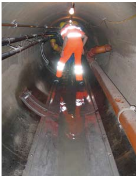
Bild 2: Trocken gelegter Abwasserkanal, Schlussabnahme der Montage der Wärmetauscherlemente
