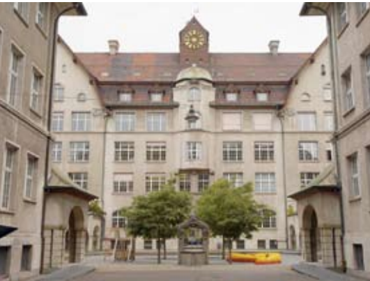
Bild 1: Das Objekt: Schulhaus Limmat, Baujahr 1909
