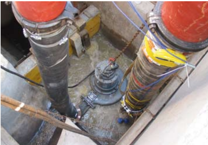
Bild 8: Der Kanalverschluss mit den Saustutzen für den Bypass
