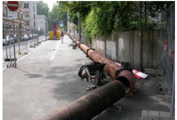
Bild 9: Der Kanalbypass, 300er-Rohr, ca. 150m lang
