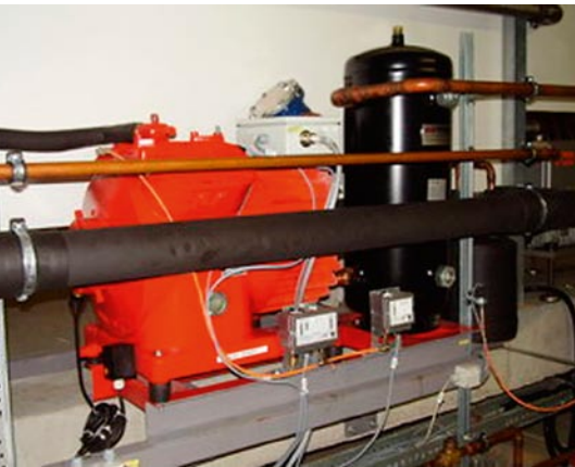
Frequenzgeregelter Verdichter
