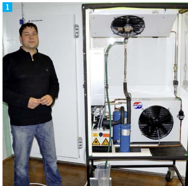
Bild 1: Martin Baur, Fachlehrer an der Staatlichen Berufsschule Lindau, mit der neuen Propan-Kälteanlage, die er zusammen mit den Schülern aufgebaut hat.
