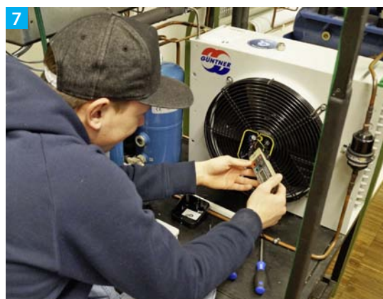
Bilder 4 bis 7: Die angehenden Mechatroniker für Kältetechnik mussten beim Aufbau der R 290-Kälteanlage ein hohes Maß an Genauigkeit und Sorgfalt walten lassen.
