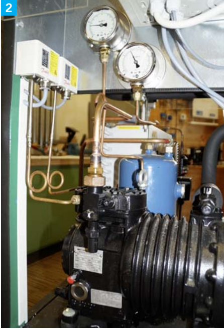
Bilder 2 und 3: Komponenten der Anlage, insbesondere die Explosionsschutzausführungen von Verdichter und Druckschaltern
